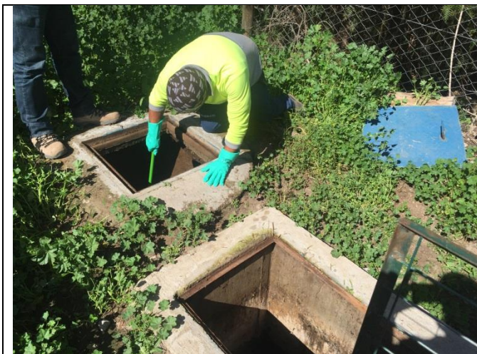
Limpieza cámara anterior a canaleta Parshall Agosto 2017
